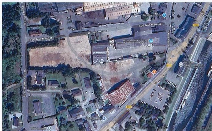
Vue du site (après la cessation de l'activité) - Le hangar en tôle a également été démolì à ce jour
